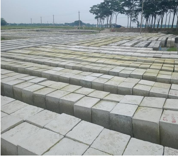
নদীর তীর প্রতিরক্ষা কাজের প্যাকেজ নং-Sunam-2/RBP/W-1 এর জন্য তৈরীকৃত ব্লকের চিত্র
