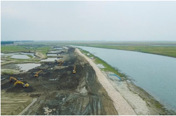
ওয়েভ প্রটেকশন কাজ
