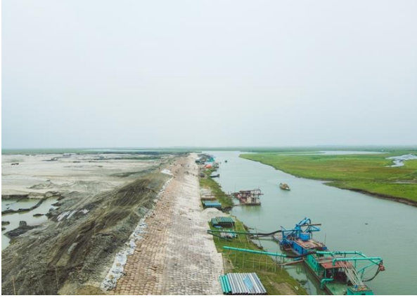
ওয়েভ প্রটেকশন কাজ
