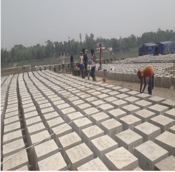
নদীর তীর প্রতিরক্ষা কাজের প্যাকেজ নং-Habi/WD-1 এর জন্য তৈরীকৃত ব্লকের চিত্র
