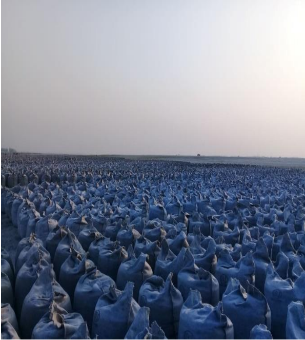
ব্রহ্মপুত্র নদের বামতীরে নদীতীর সংরক্ষণ কাজের চলমান কাজের স্থির চিত্র
