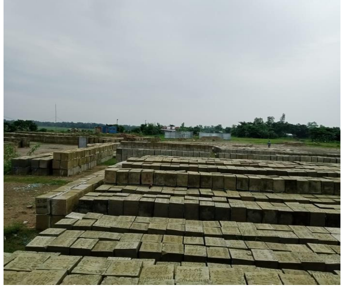
নদীর তীর প্রতিরক্ষা কাজের প্যাকেজ নং-Habi/WD-1 এর জন্য তৈরীকৃত ব্লকের চিত্র
