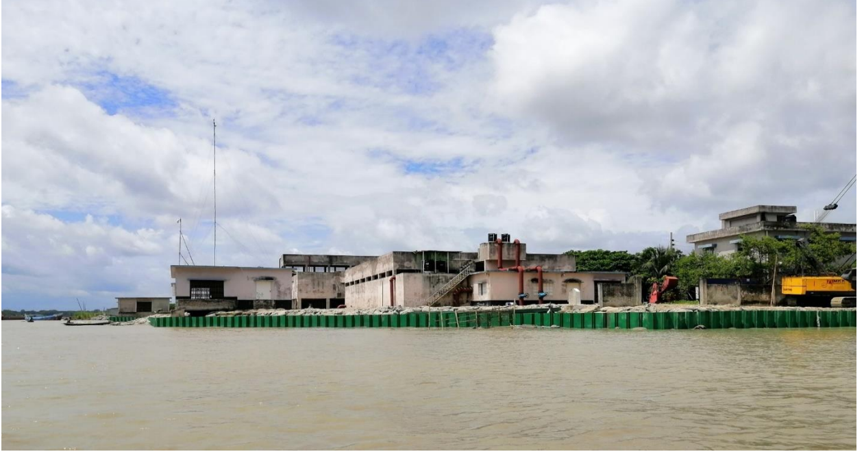
ওয়াটার ট্রীটমেন্ট প্ল্যান্টকে নদী ভাঙ্গন হতে রক্ষার্থে ড্রাইভিংকৃত সিট পাইল
