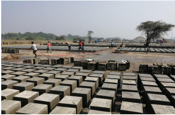
প্রতিরক্ষা কাজের ব্লক তৈরীর চিত্র
