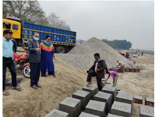
চলমান নদীতীর সংরক্ষণ কাজের জন্য ব্যবহৃত সিসি ব্লক নির্মাণের স্থিরচিত্র
