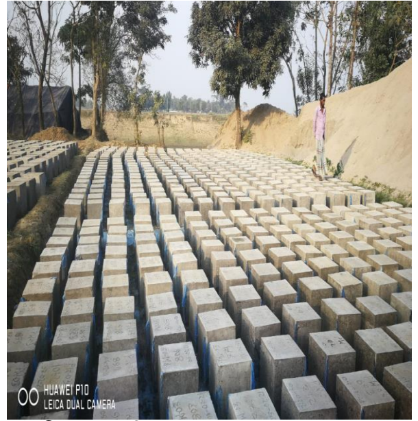
নদীর তীর প্রতিরক্ষা কাজের জন্য তৈরীকৃত ব্লকের চিত্র
