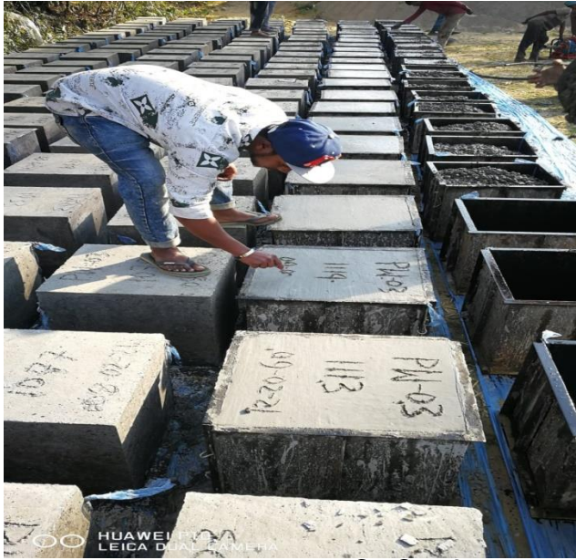
নদীর তীর প্রতিরক্ষা কাজের জন্য তৈরীকৃত ব্লকের চিত্র
