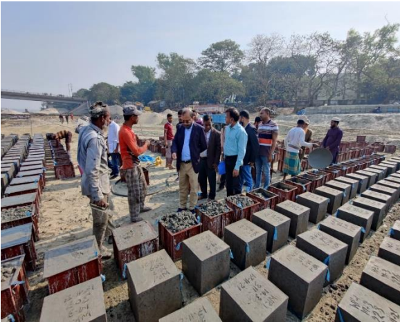
চলমান নদীতীর সংরক্ষণ কাজের জন্য ব্যবহৃত সিসি ব্লক নির্মাণের স্থিরচিত্র
