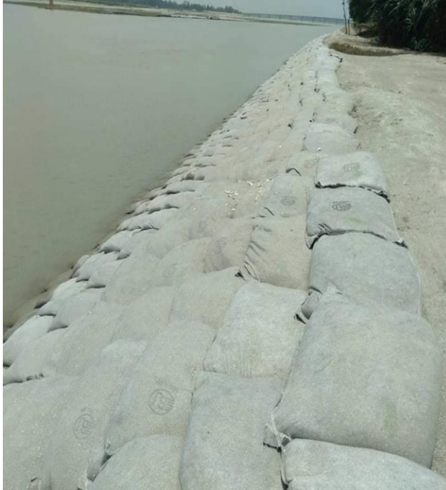
নদীতীর সংরক্ষণ কাজের চলমান কাজের স্থির চিত্র
